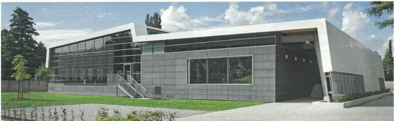
▲ Rückwärtige Ansicht Erschließung Stellplatzanla- ge und Technikzugang
