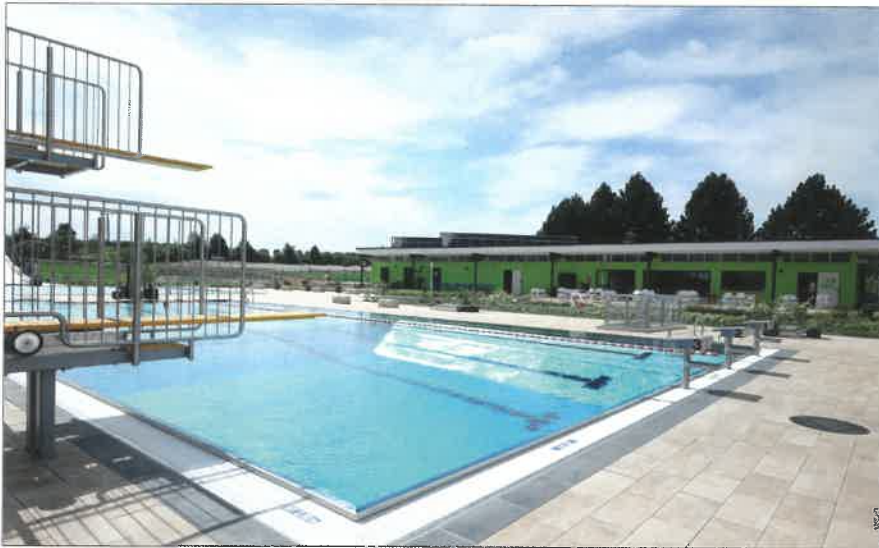
■ Neue Sprunganlage und Beckenauskleidung
