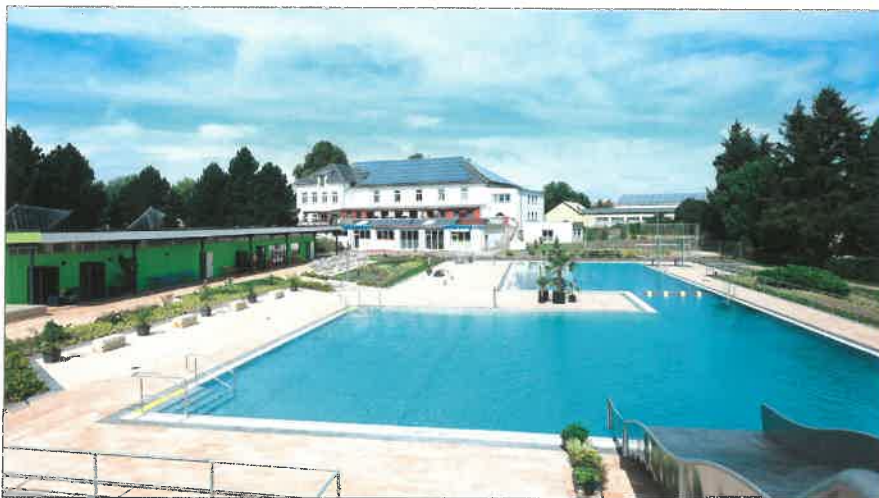
■ Blick von der Wellenreittrutsche, links das sanierte Eingangs- und Umkleidegebäude; das Gebäude im Hintergrund gehört nicht zum Freibad; Fotos: Bauplanungsbüro Schroeder | architektur, Döbeln
