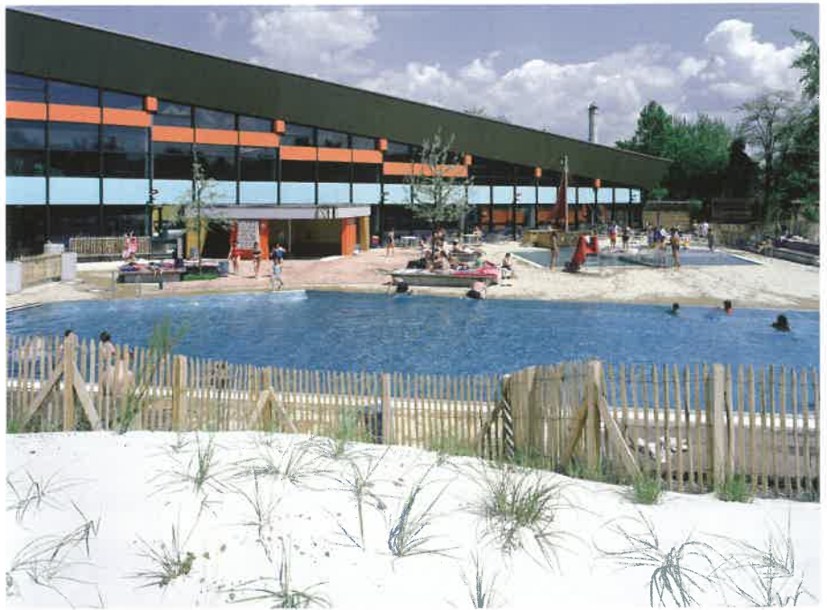
Badeplattform mit Nichtschwimmer- und Kleinkindbecken vor der Hallenbadfassade
