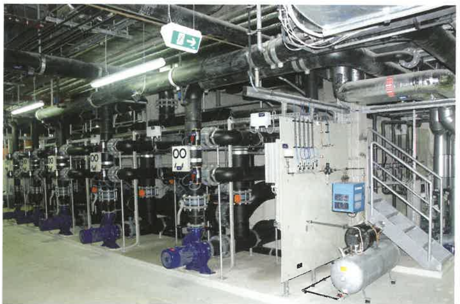
Frontverrohrung der offenen Sandfilter und Dosierstation; Foto: Wassertechnik Wertheim, Wertheim
