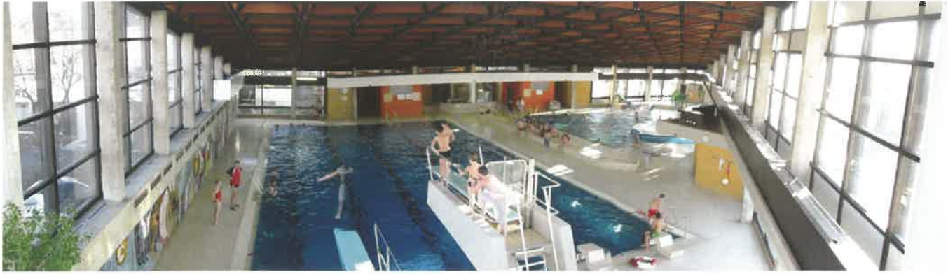
Die Schwimmhalle vor der Sanierung; Foto: KölnBäder
